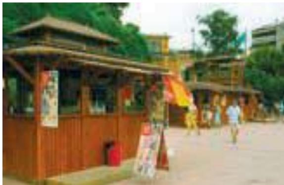
Estructuras de madeira de pinho silvestre, que acompanham a as casitas, com uma estrutura porticada perimetral y um pilar interior. Com referência ao revestimento pode ser bom mediante uma lona ignífuga certificada (M2)
